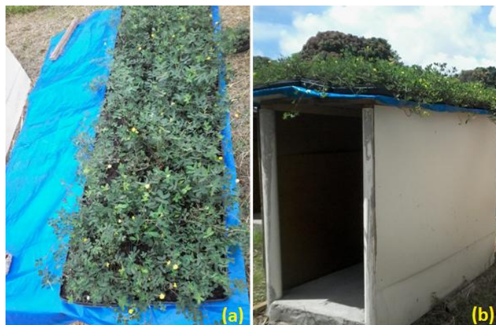
Figura 11. Impermeabilização e montagem do telhado verde ( Arachis repens ).
