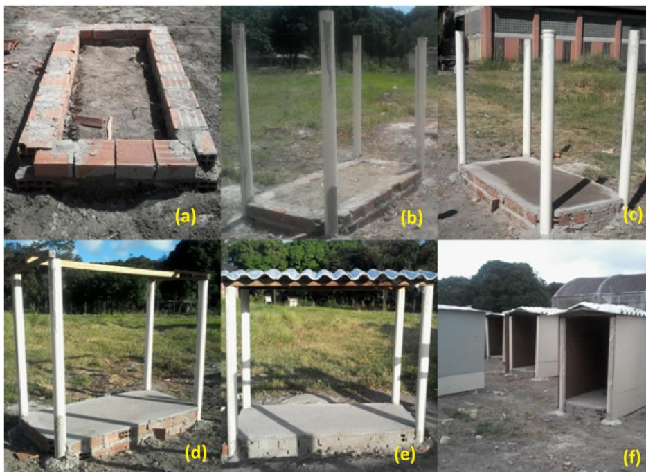
Figura 7. Etapas da construção dos modelos reduzidos. (a) base de tijolos com 30 cm; (b) tubos de pvc (100 mm) preenchidos por concreto; (c) piso de concreto; (d, e) armação de ripas de madeira para suporte dos telhados; (f) fechamento lateral com chapas de fibra de madeira.
