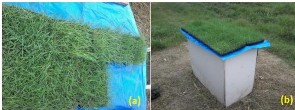
Figura 10. Impermeabilização e montagem do telhado verde ( Zoysia japonica ).
